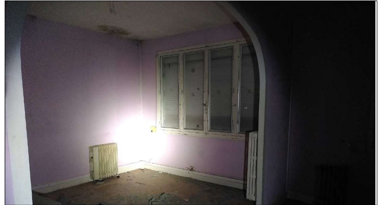
Photo 136: vue de l'intérieur de la maison – décembre 2021
