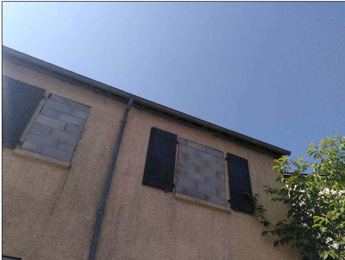
Photo 135: vue de la façade nord de la maison – Été 2021
