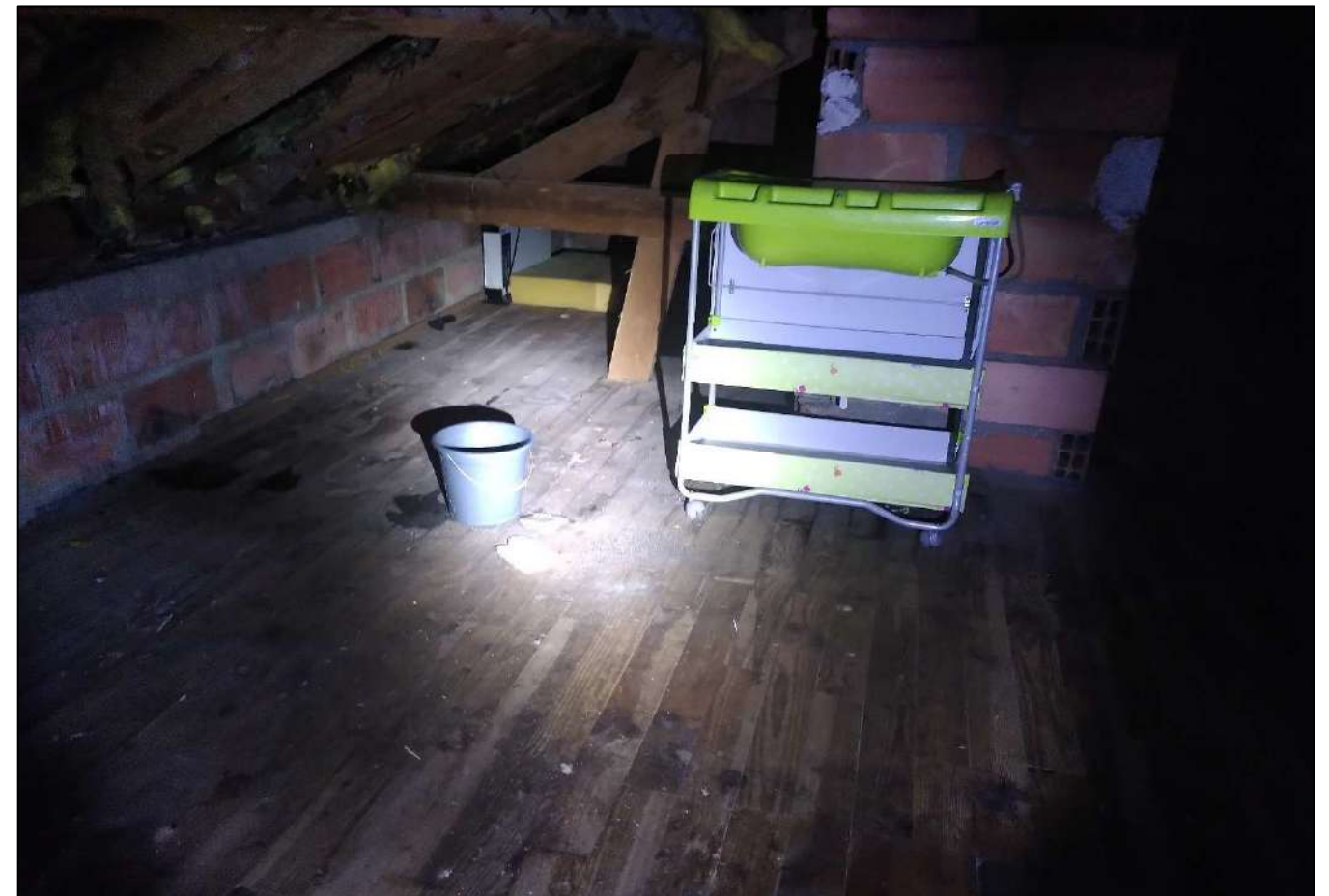
Photo 137: vue des combles de la maison – décembre 2021
