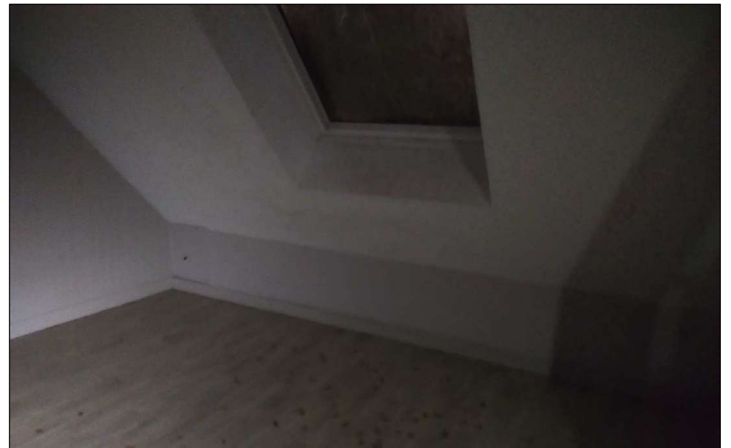
Photo 141/ vue de l'intérieur de la maison - décembre 2021
