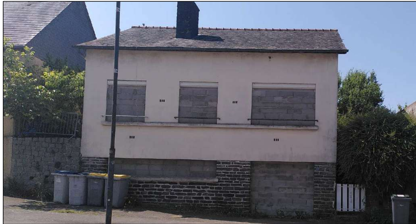
Photo 138: vue de la façade nord - été 2021
